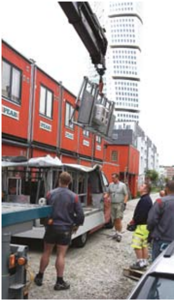
Arbete i full gång – bänkskivor lastas av för montering i Västra Hamnen i Malmö.
