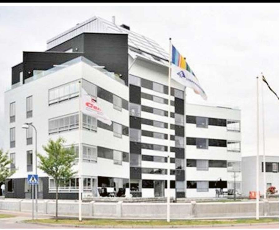
Huset med vy från söder
