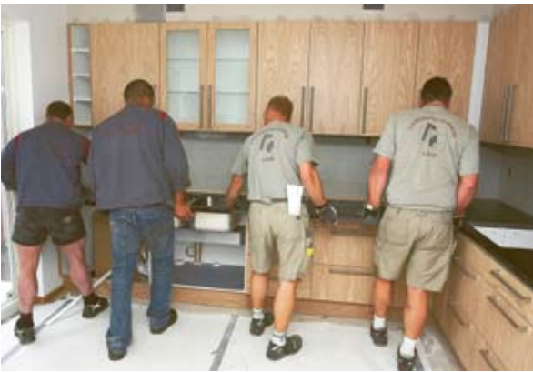
Montering av köksbänk; kvalitet väger!
