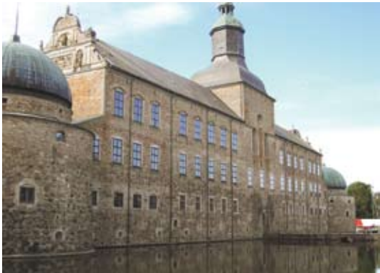
Vadstena slott är ett av landets bäst bevarade renässansbyggen; en sluten försvarsanläggning med massiva murar av kalksten och olika sorters lokal fältsten. Murarna har varit putsade. Foto: Thuresson.
