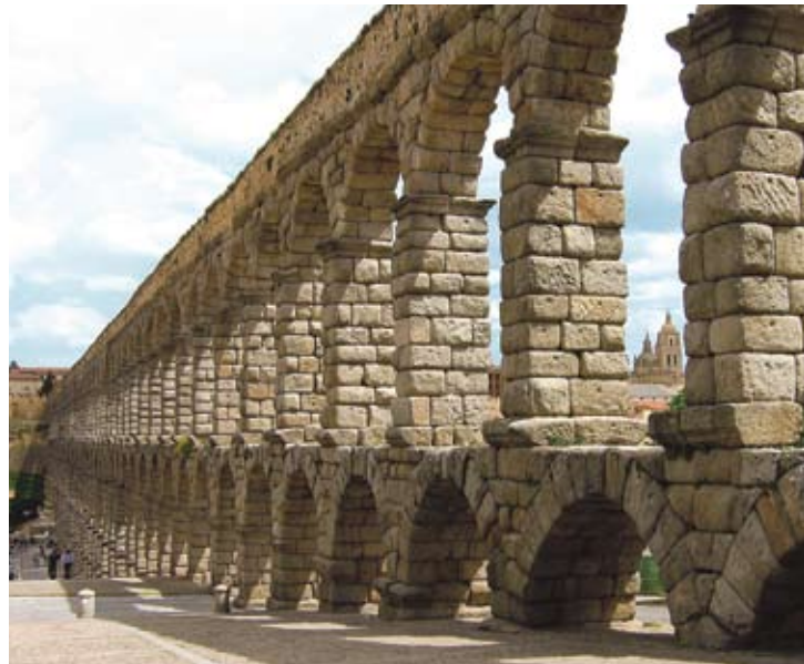
Akvedukten i Segovia är det största romerska byggnadsverket i Spanien. Den är byggd av granitblock utan murbruk och hålls på plats genom dess konstruktion och materialets tyngd.
